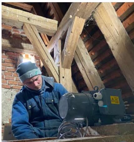
Maximilian Schleifer von der Fa. Hörz beim Einbau des neuen Läutwerks im Glockenturm von St. Martin.
