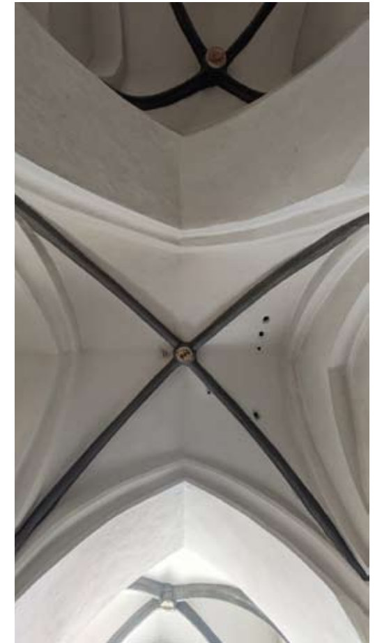
Erstrahlt im neuen Glanz: Das Kreuzrippengewölbe der Kirche St. Peter und Paul in Oberalting.
